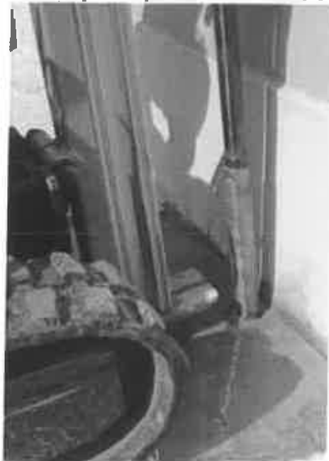
Perforazione della fondazione con carotatrice fino al raggiungimento del terreno sottofondale
