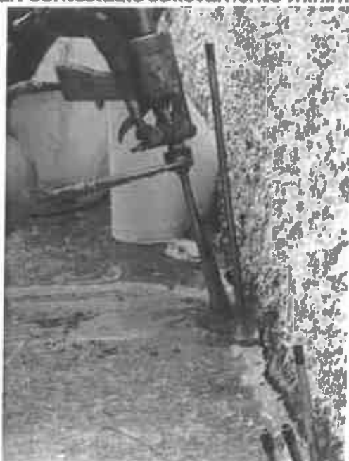
Inserimento della armatura e successiva iniezione di polimeri espandenti all'interno del foro precompattato
