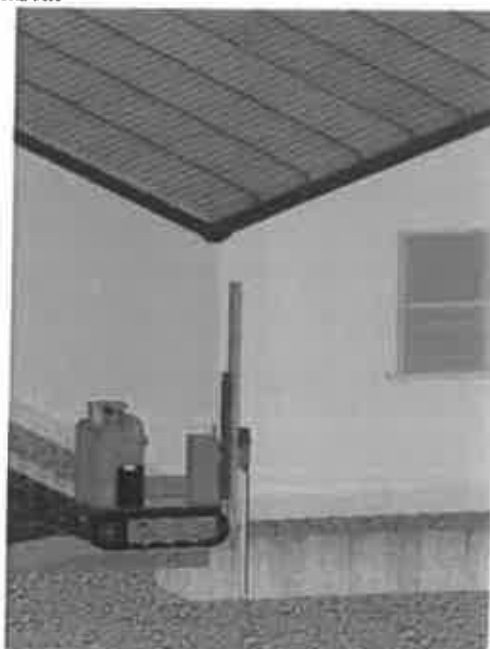
Perforazione della fondazione con carotatrice fino al raggiungimento del terreno sottofondale
