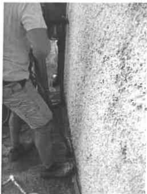
Inserimento del perforatore pneumatico all'interno del carotaggio
