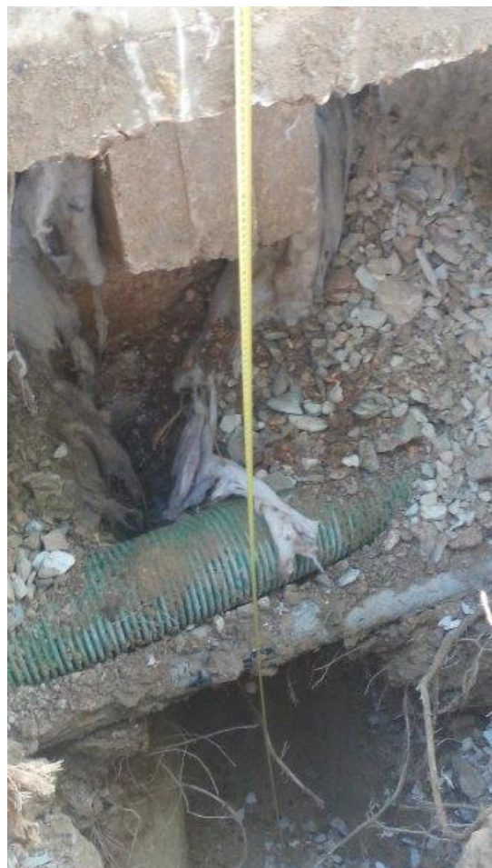
Foto 2: scavo in aderenza alla fondazione
