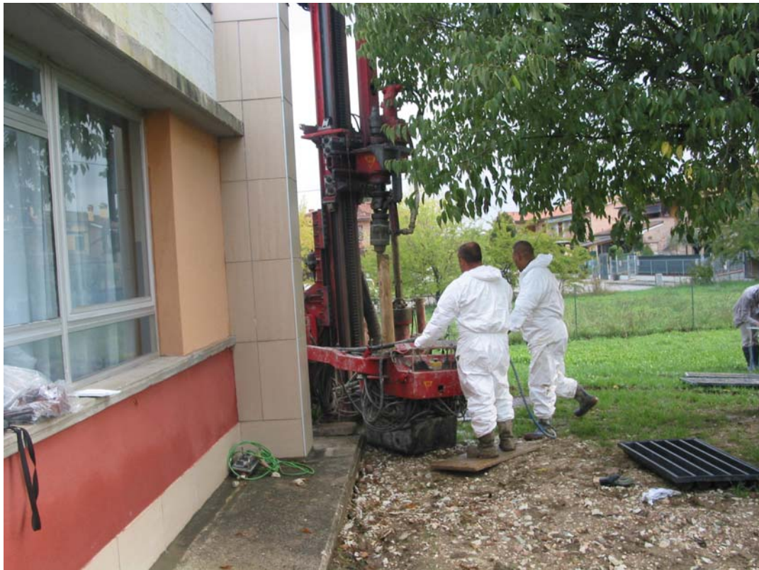
Foto 1: sondaggio stratigrafico
