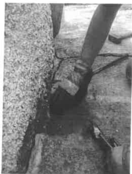
Taglio dei condotti di iniezioni a livello della pavimentazione.
