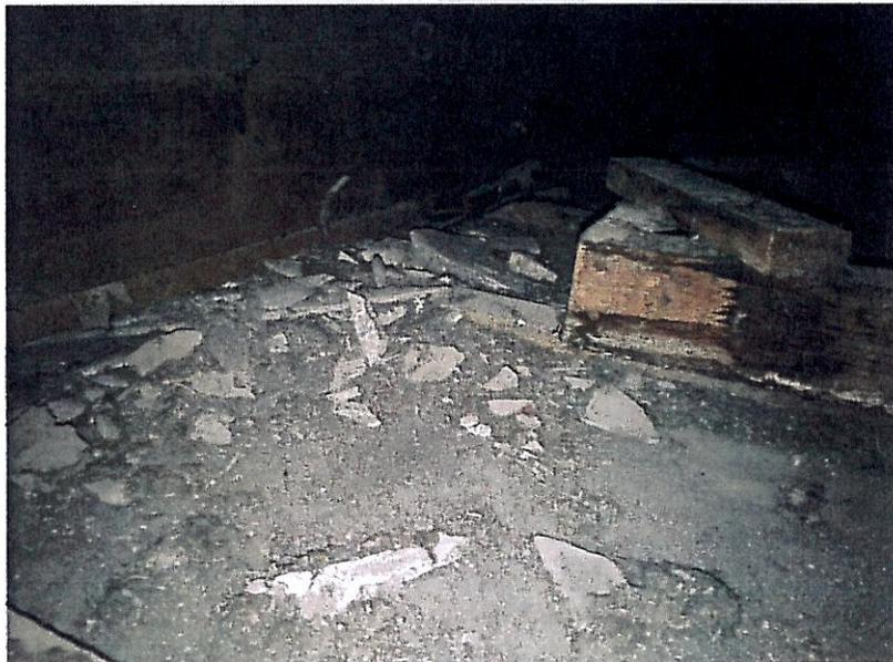
Foto n. 4 – Materiale in cemento-amianto presente nell'intercapedine tra la controsoffittatura e la copertura.
